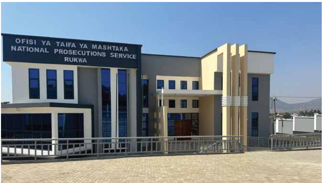
Jengo la Ofisi ya Taifa ya Mashtaka Mkoa wa Rukwa linalowakilisha Majengo yote ya Mikoa yanayojengwa.
